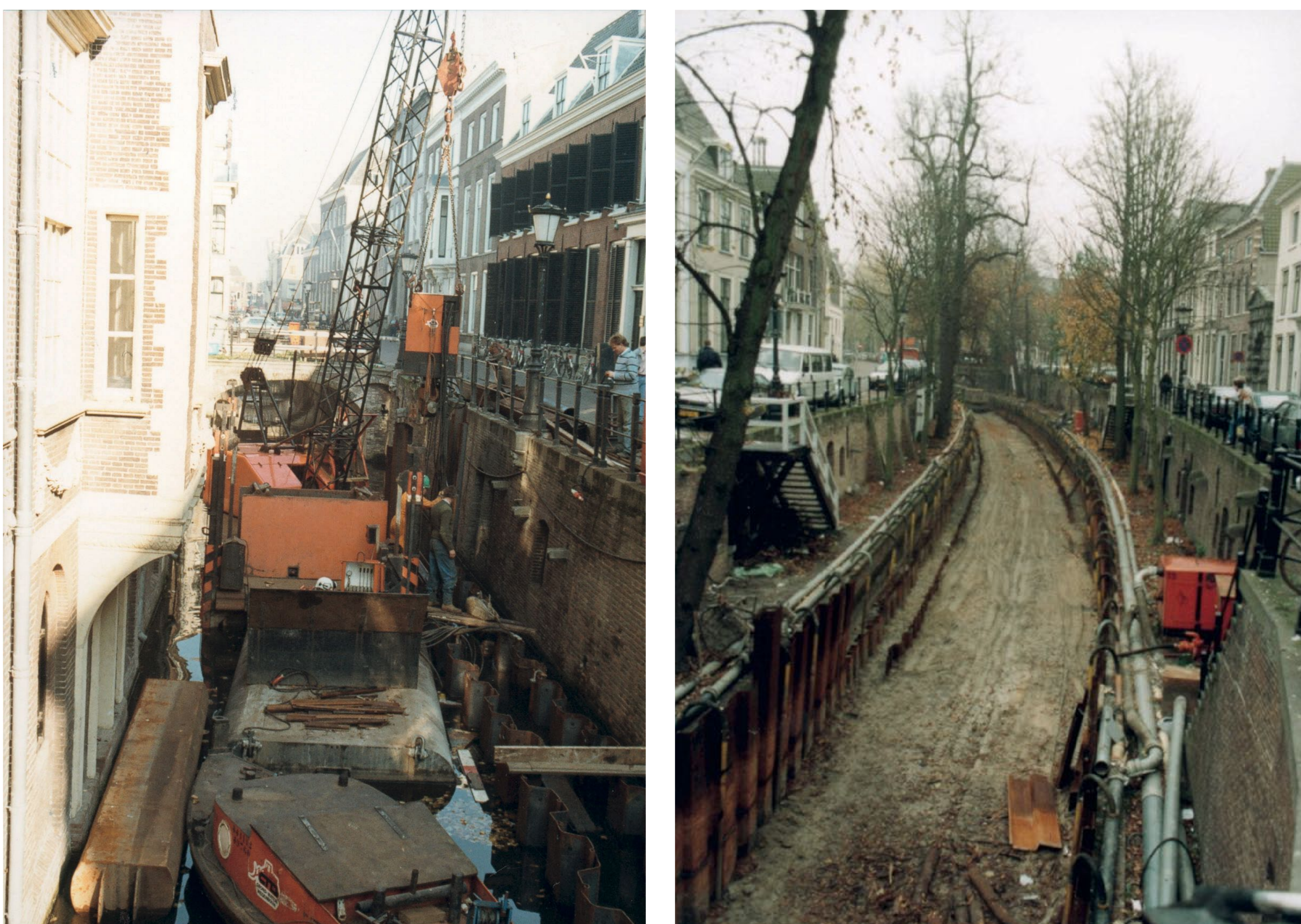
Aanleg van het grachtriool in de 80-er jaren
